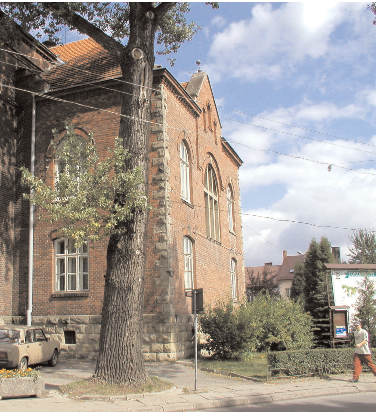
I Jordanóws stadshus har energieffektiv belysning installerats med hjälp av Pico-finansiering.
